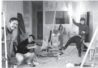
店舗の施工ワークショップ風景
