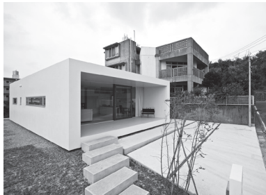
伝統的な知恵をとり入れた沖縄の住宅
