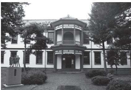
国重要文化財「旧福島県尋常中学校本館」修復
