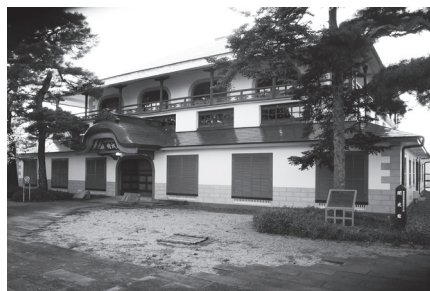
県重要文化財「開成館」修復
