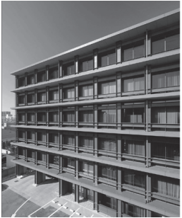
千葉農業会館の外部補強(既存建物と調和するグリッドフレーム補強)
