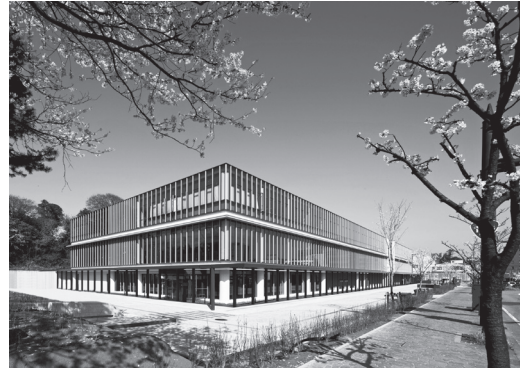
名古屋高蔵金沢支部・金沢地家簡裁庁舎 外観
